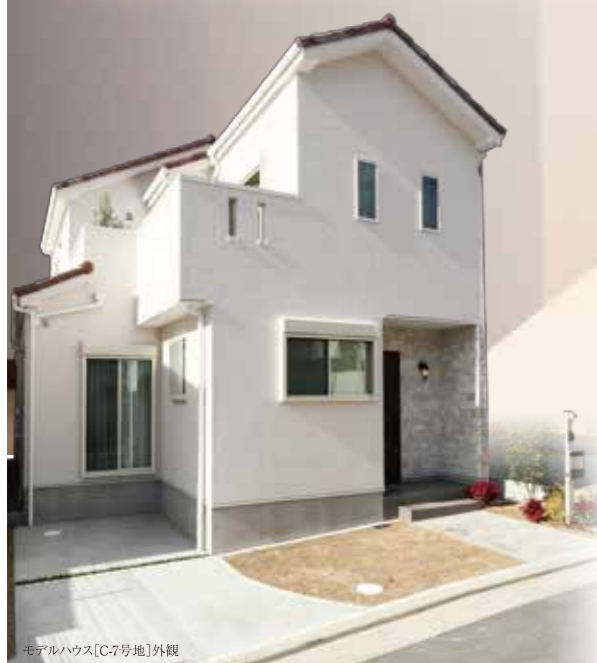
モデルハウス[C-7号地]外観
